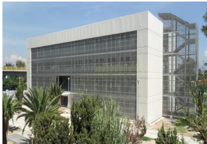
Infraestructura del Edificio del ITGAM
