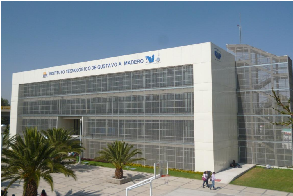
Fachada principal del Edificio tipo IV del ITGAM
